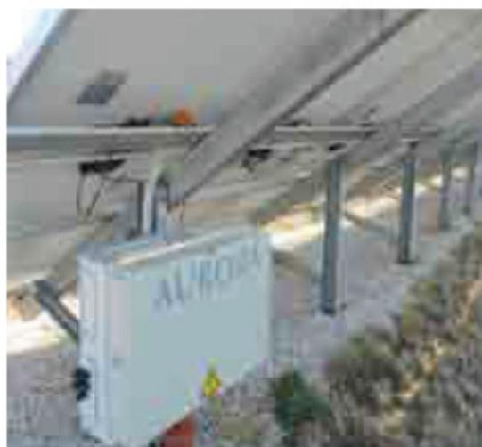
«Abbiamo prestato una cura particolare alla fase del cablaggio - spiegano gli autori dell'intervento -. Un'operazione che abbiamo effettuato sul campo e che ha comportato molte ore di lavoro e un livello di attenzione altissimo. Tutti i connettori infatti devono essere il più puliti possibile e le condizioni atmosferiche della stagione autunnale hanno spesso intralciato questo lavoro»
